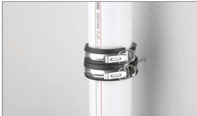
Εικ. 7-3 Έτοιμη, εγκατεστημένη στερέωση-στήριξη
